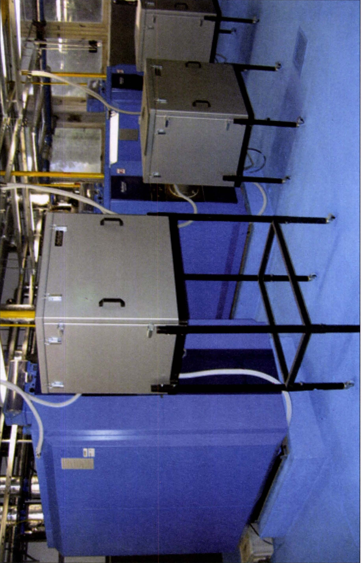
KENDİNDEN YOĞUŞMALI ÜÇ TAM GEÇİŞLİ KAZAN (1.200 kW) (Solda), ECOSTREAM ESNEK DÖKÜM KAZANLAR (2 x 510 kW) (Sağda) ve ÖZEL SUSTURUCULU KURUM YAPMAYAN ORANSAL BRÜLÖRLER
