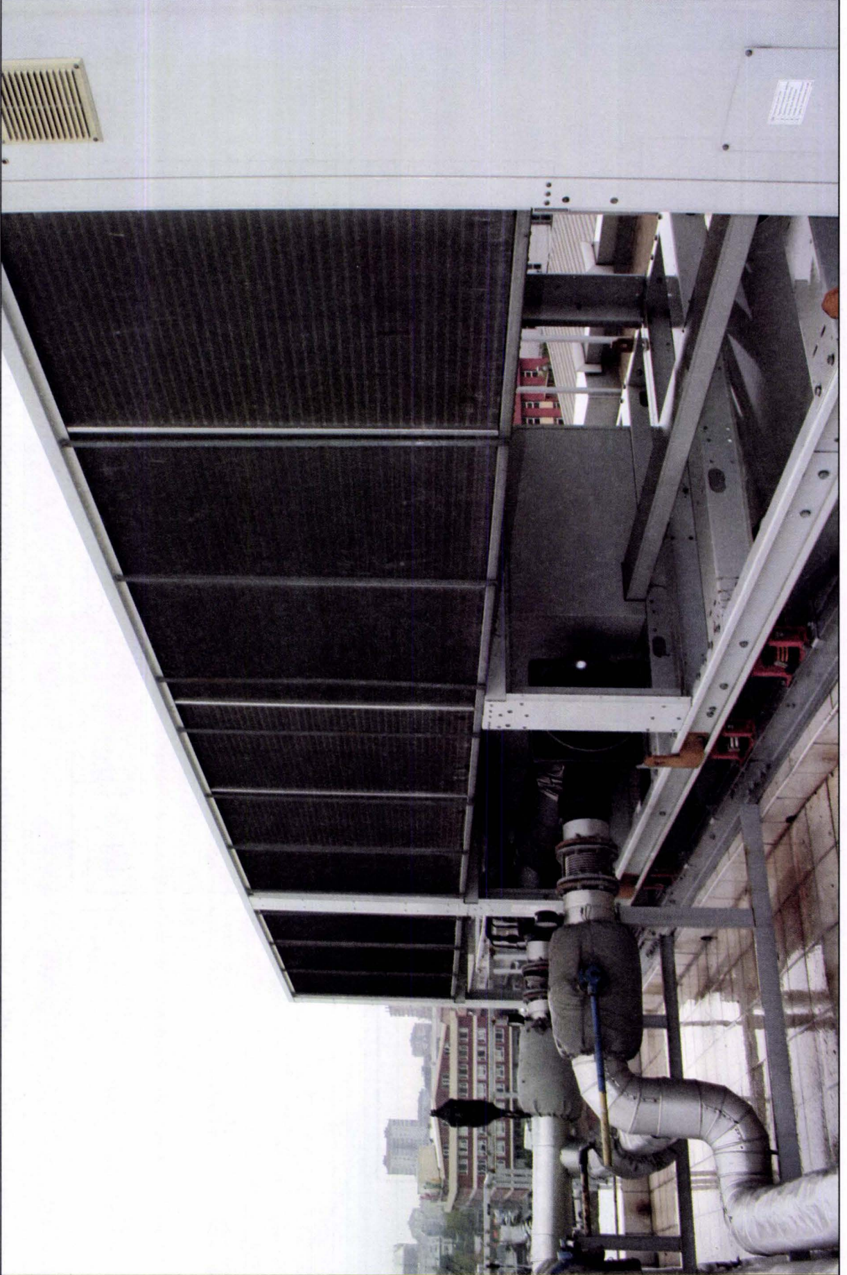
Şekil 2.42. HAVA SOĞUTMALI SU SOĞUTMA GRUPLARI SOĞUTMA KAPASİTESİ: 750 kW
