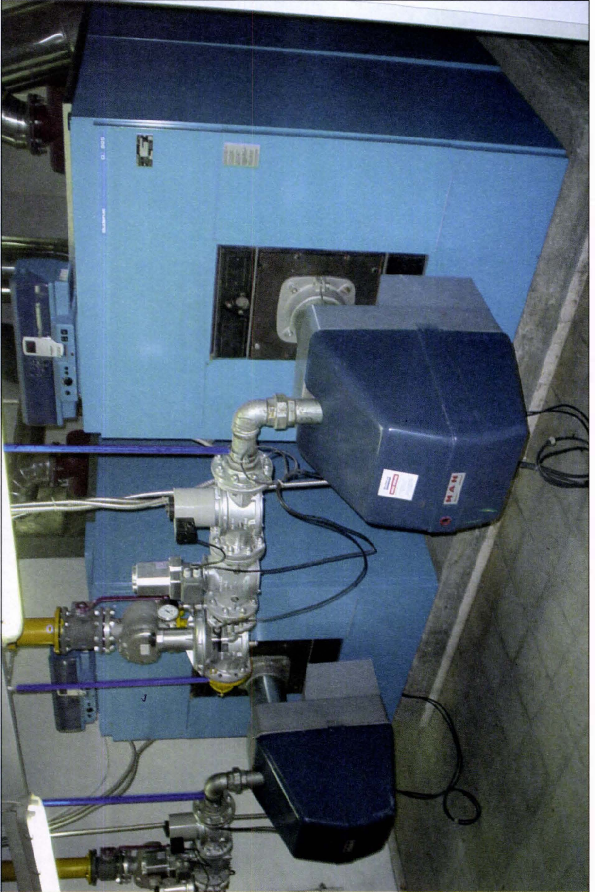
ECOSTREAM ESNEK DÖKÜM KAZANLAR (1.200 kW x 2) VE İKİ KADEMELİ BRÜLÖRLER
