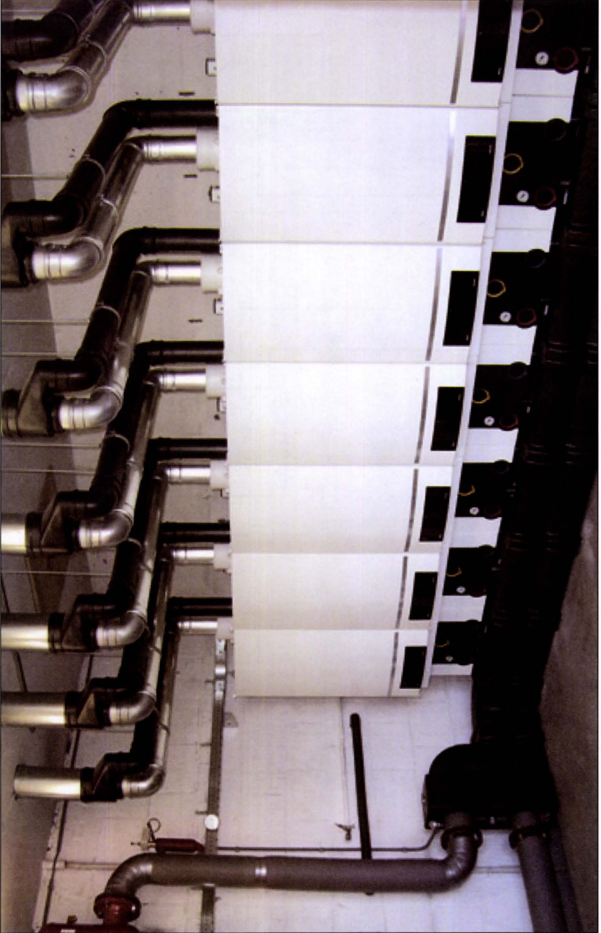
%110 VERİMLİ DUVAR TİPİ YOĞUŞMALI KASKAD SİSTEM (8 x 100 kW = 800 kW) (Özel hermetik baca bağlantısı ve özel hazır kaskad bağlantı seti)
