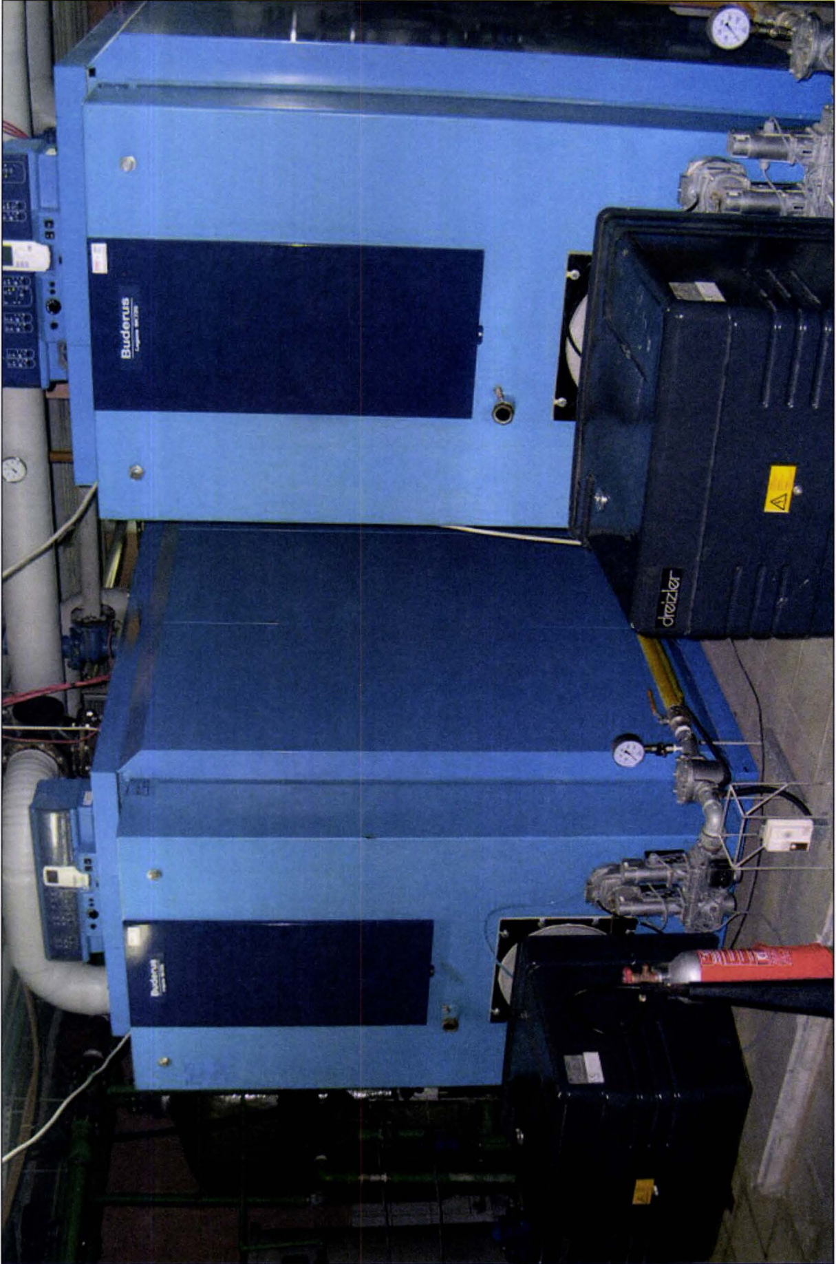
ECOSTREAM ÇELİK KAZAN (2 x 1.750 kW) VE KURUM YAPMAYAN ORANSAL BRÜLÖRLER
