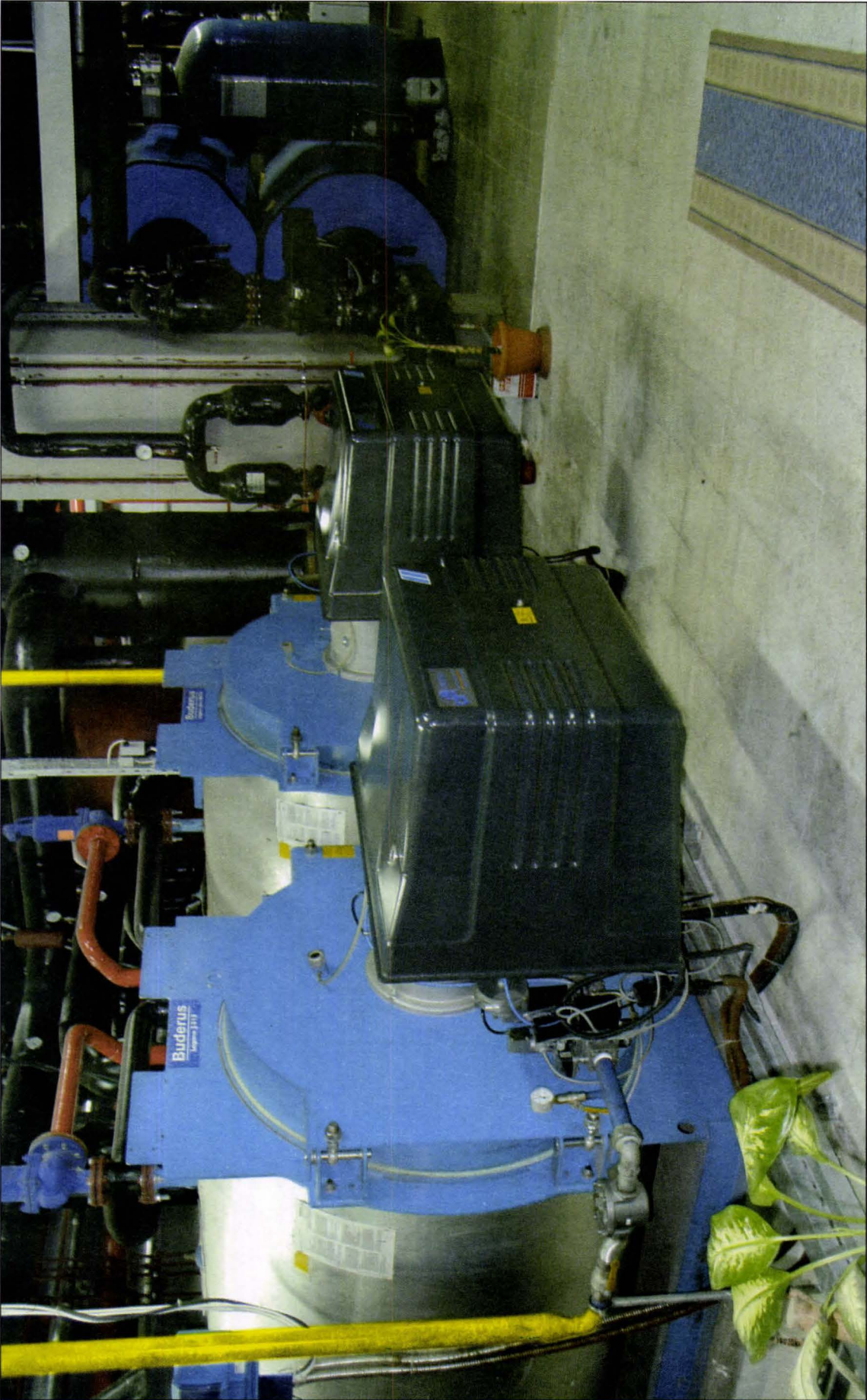
TÜRBÜLATÖRSÜZ ÜÇ TAM GEÇİŞLİ KAZANLAR (2.500 kW x 2) VE YATIK TIP HIJYENİK BOYLERLER (2 x 3.000 l = 33.000 l/h)
