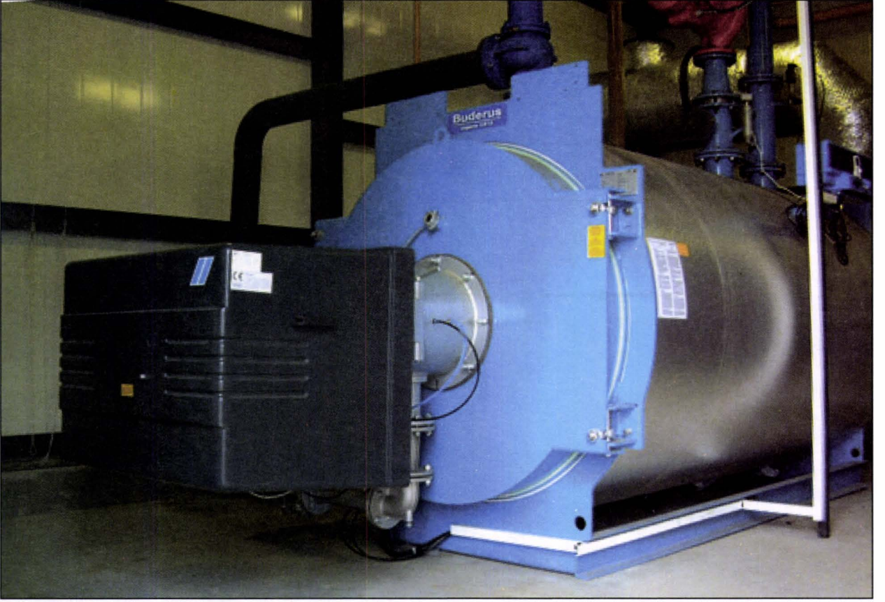
TÜRBÜLATÖRSÜZ ÜÇ TAM GEÇİŞLİ KAZAN (3.700 KW) ve KURUM YAPMAYAN ORANSAL BRÜLÖR
