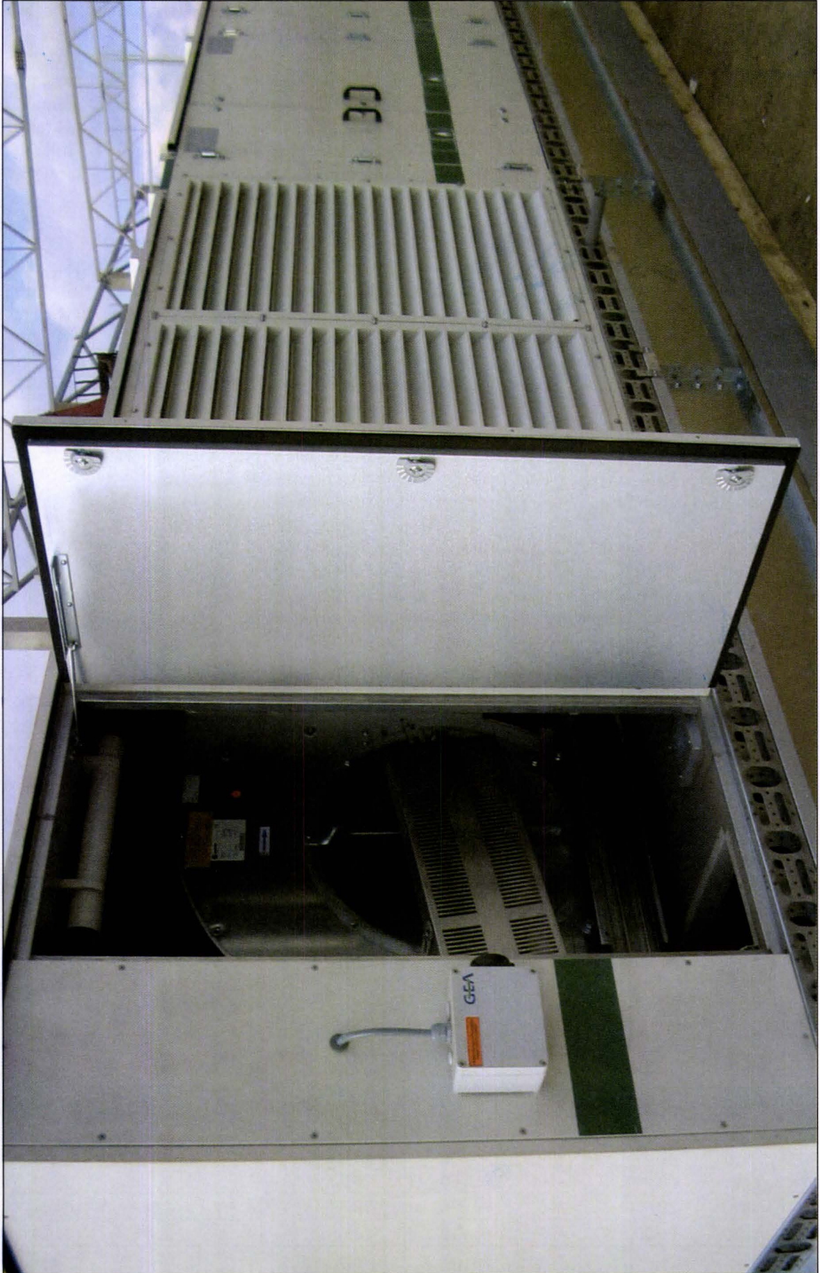
Şekil 2.21. HARİCİ TIP KARIŞIM HAVALI KLİMA SANTRALI - 20.000 m 3 /h (Enerji kaybını engellemek için kanal ve serpantin bağlantıları alttan)
