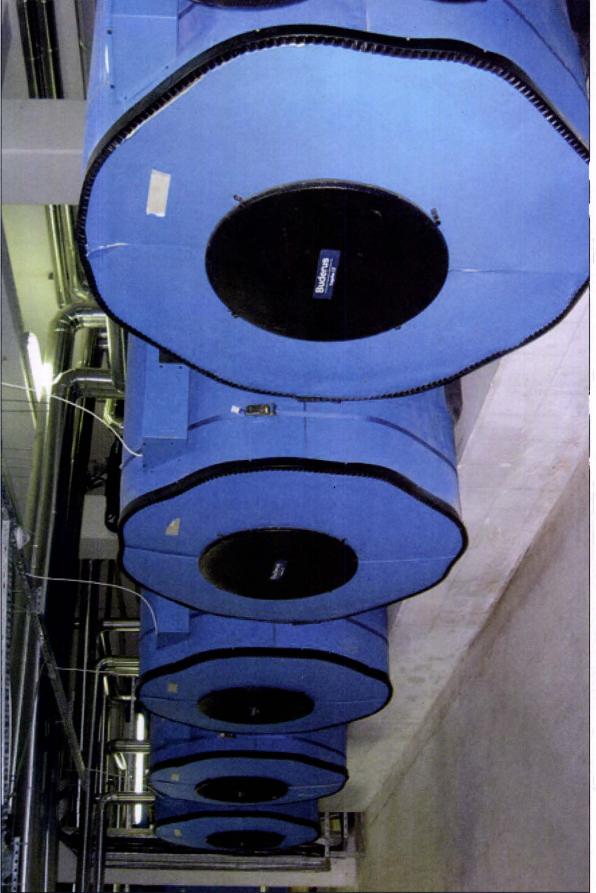
GÜNEŞ ENERJİSİ SİSTEMİ AKÜMÜLATÖR TANKI YERLEŞİMİ (OTEL UYGULAMASI)
