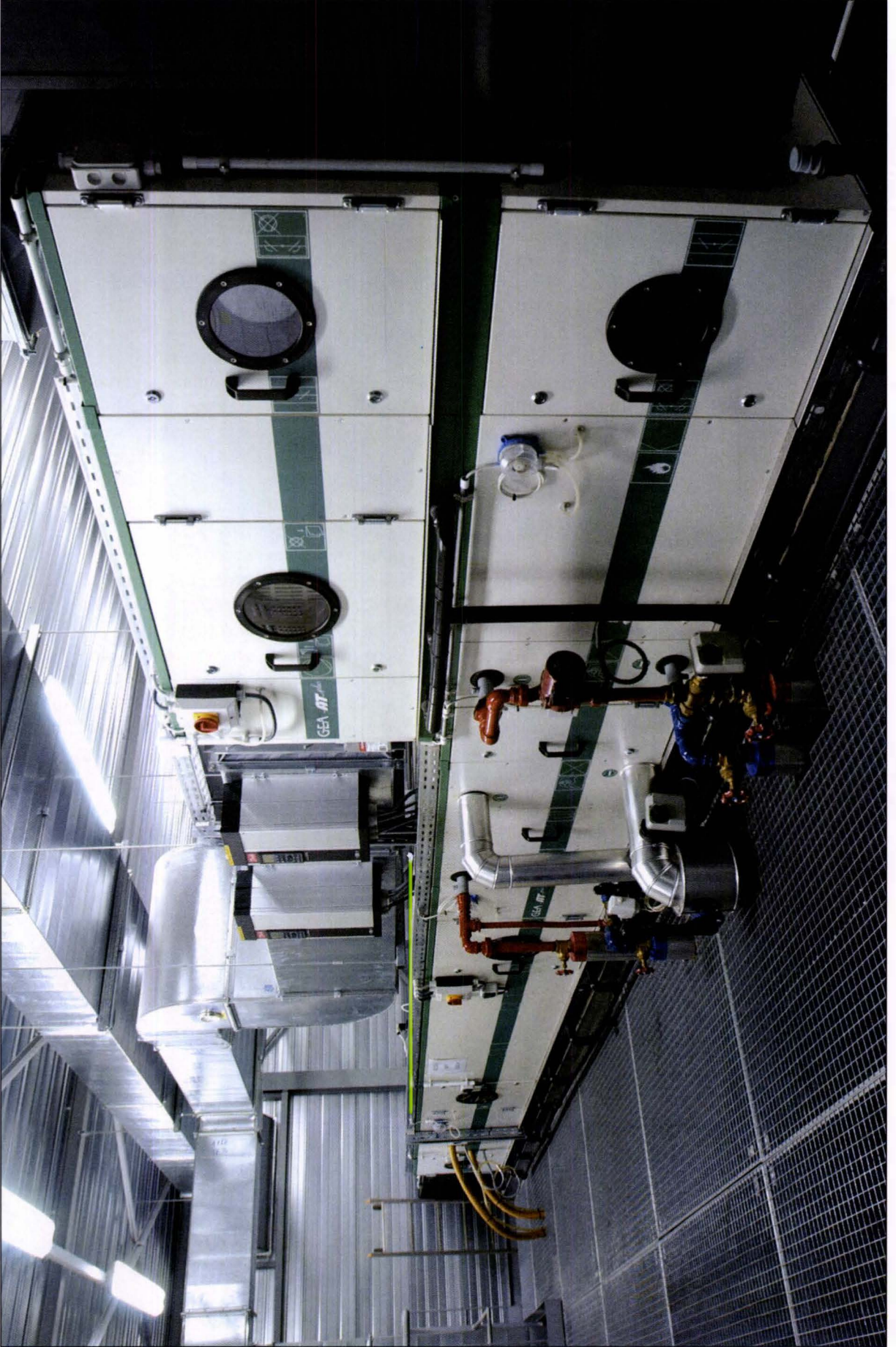
Şekil 2.14. BUHARLI, NEMLENDİRİCİLİ, FREKANS İNVERTER FAN KONTROLLÜ HİJYENİK TİP KLİMA SANTRALI - 8.500 m 3 /h
