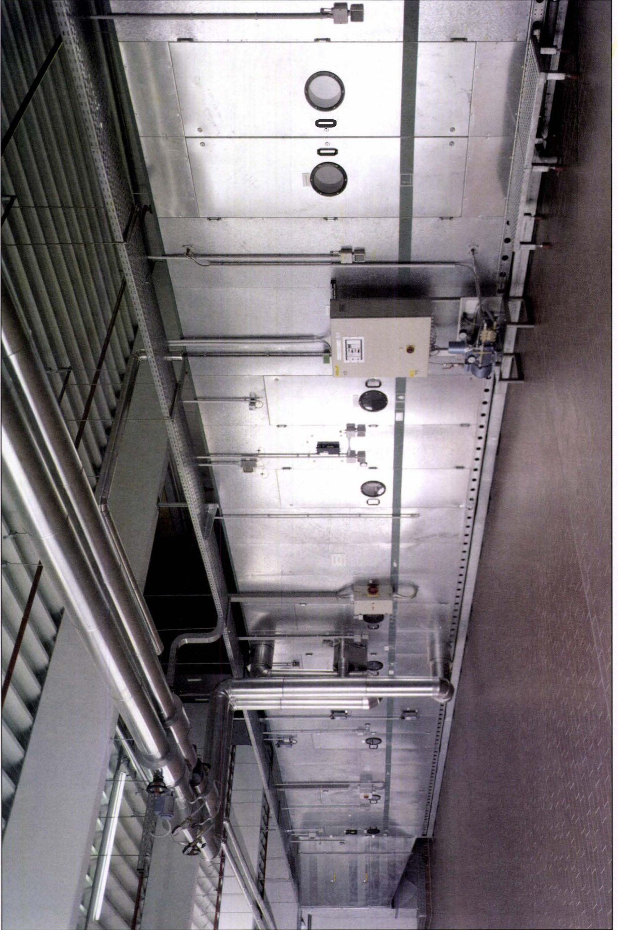
Şekil 2.17. YIKAMALI TIP NEMLENDİRİCİ HÜCRELİ MATBAA KLİMA SANTRALI (Kombi) - 60.000 m 3 /h
