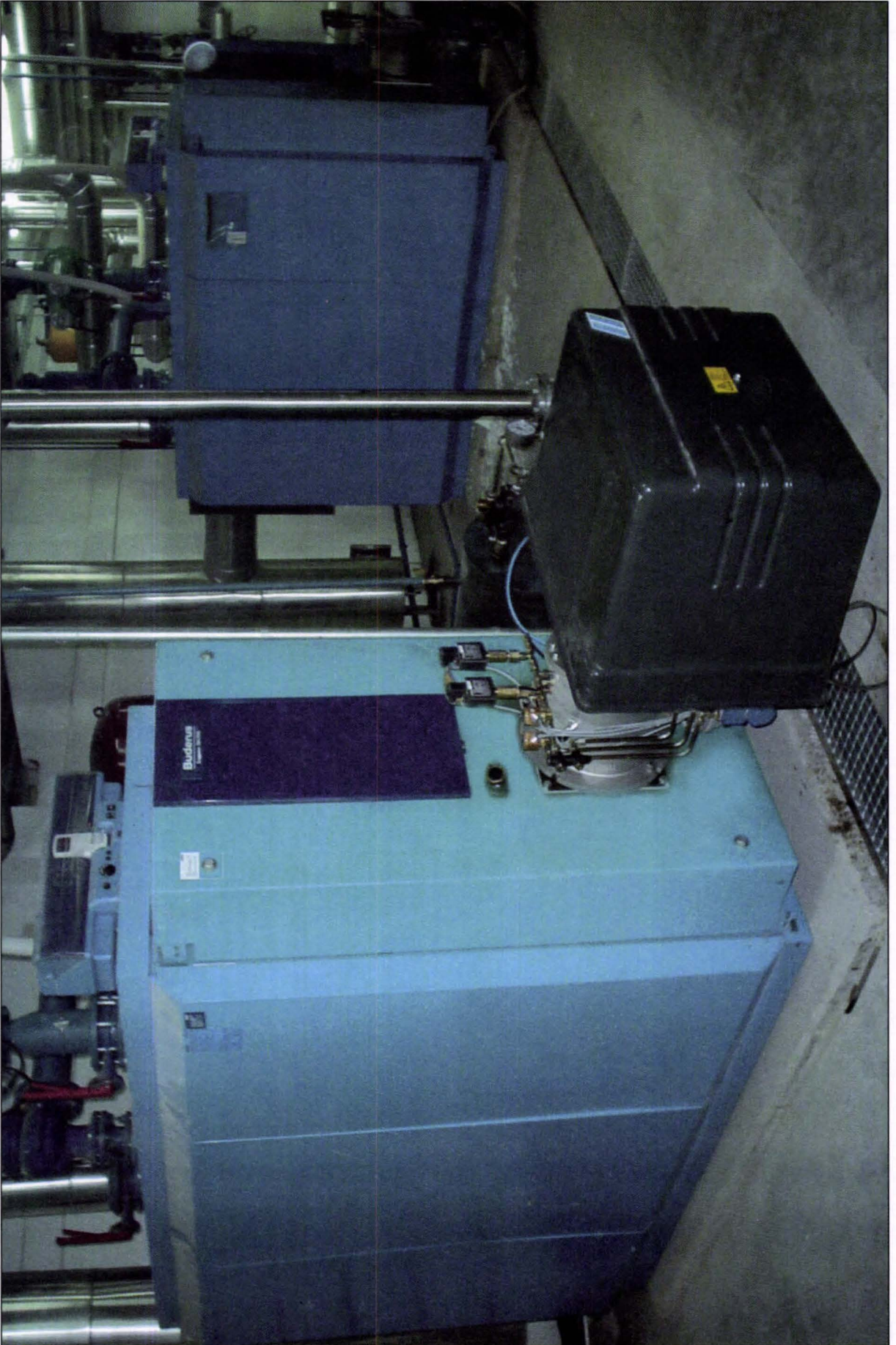
ECOSTREAM ÇELİK KAZANLAR (2 x 1.400 kW) VE KURUM YAPMAYAN ORANSAL BRÜLÖRLER (Soldaki brülör çift yakıtlı tip)
