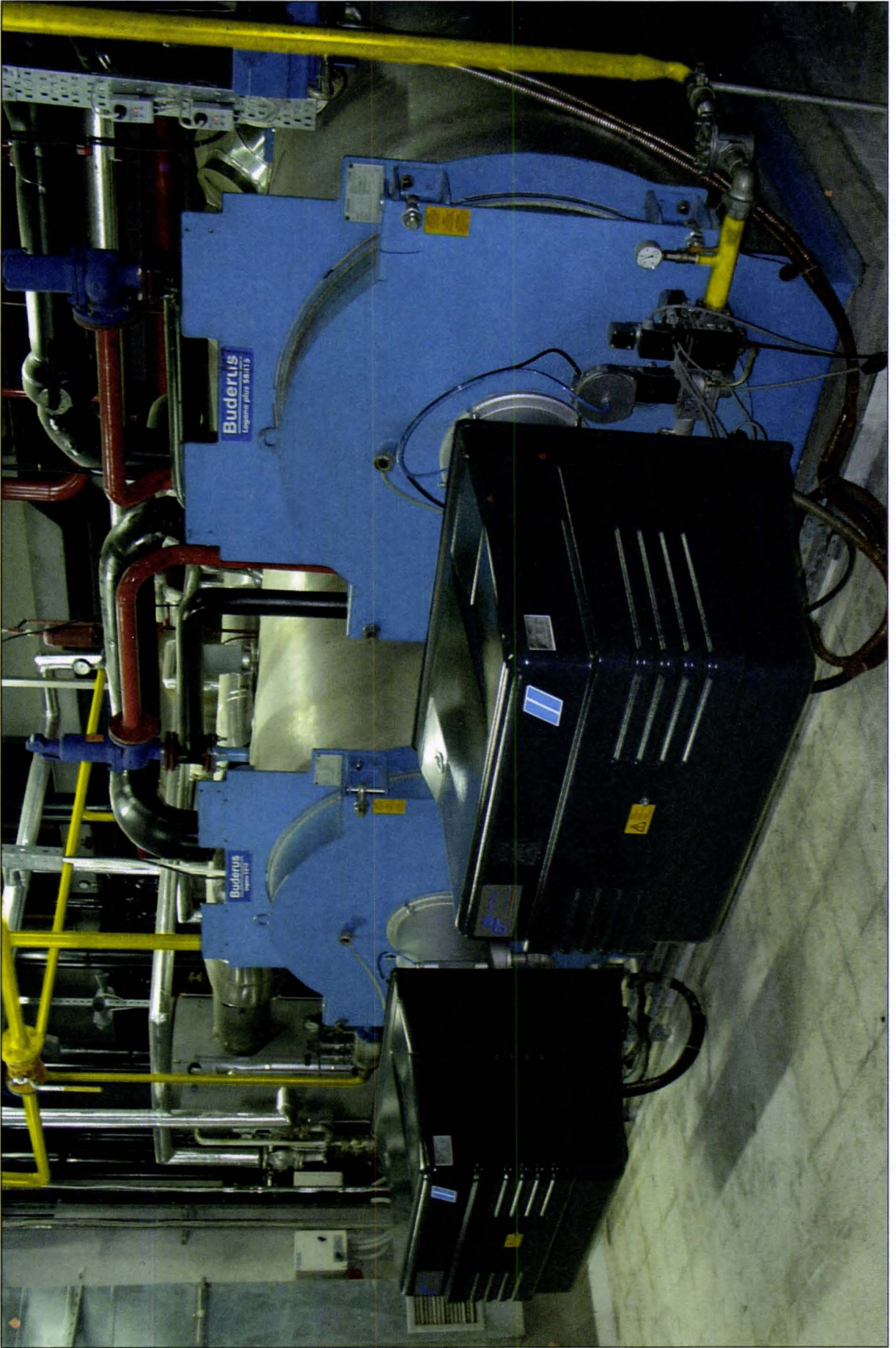
TÜRBÜLATÖRSÜZ ÜÇ TAM GEÇİŞLİ KAZANLAR (2.500 kw x 2) VE KURUM YAPMAYAN ORANSAL BRÜLÖRLER
