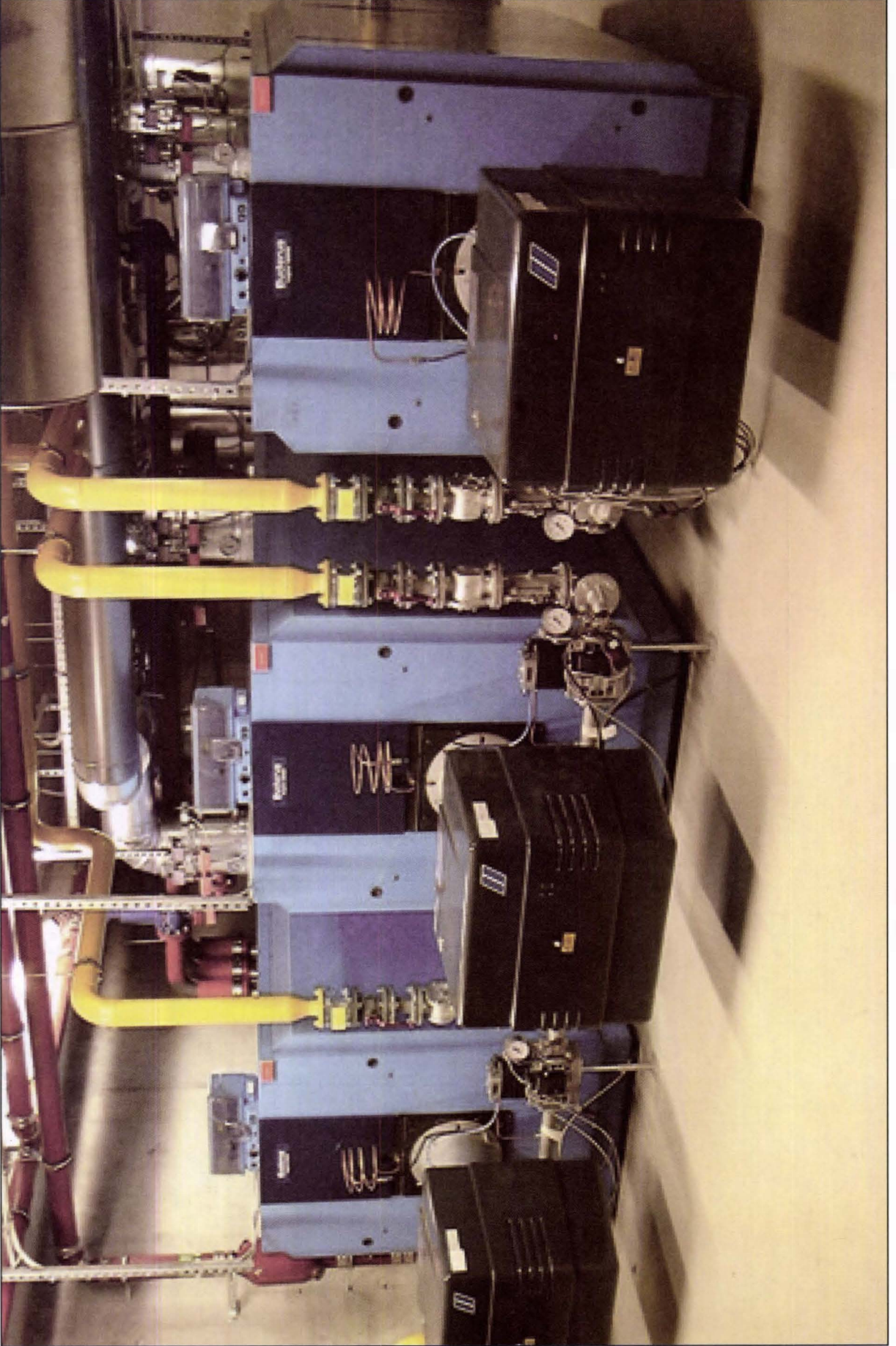
ECOSTREAM ESNEK DÖKÜM KAZAN (3 x 1.200 kW) VE KURUM YAPMAYAN ORANSAL BRÜLÖRLER
