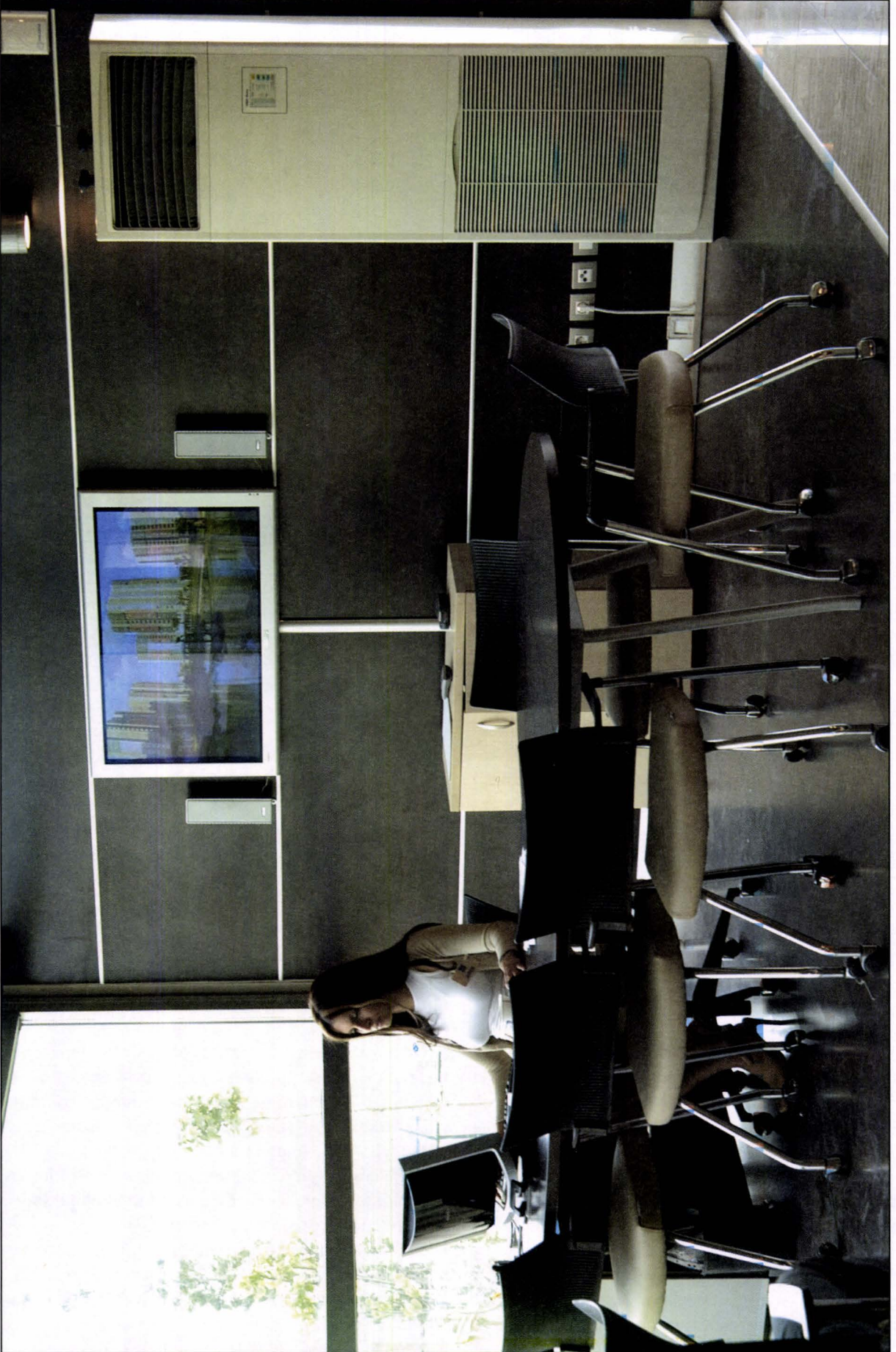
Şekil 2.104. SALON TİPİ SPLIT KLİMA UYGULAMA ÖRNEĞİ
