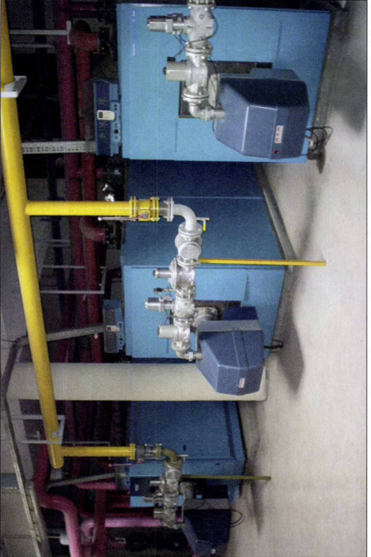
ECOSTREAM ESNEK DÖKÜM KAZANLAR (3 x 1.200 kW) VE İKİ KADEMELİ BRÜLÖRLER
