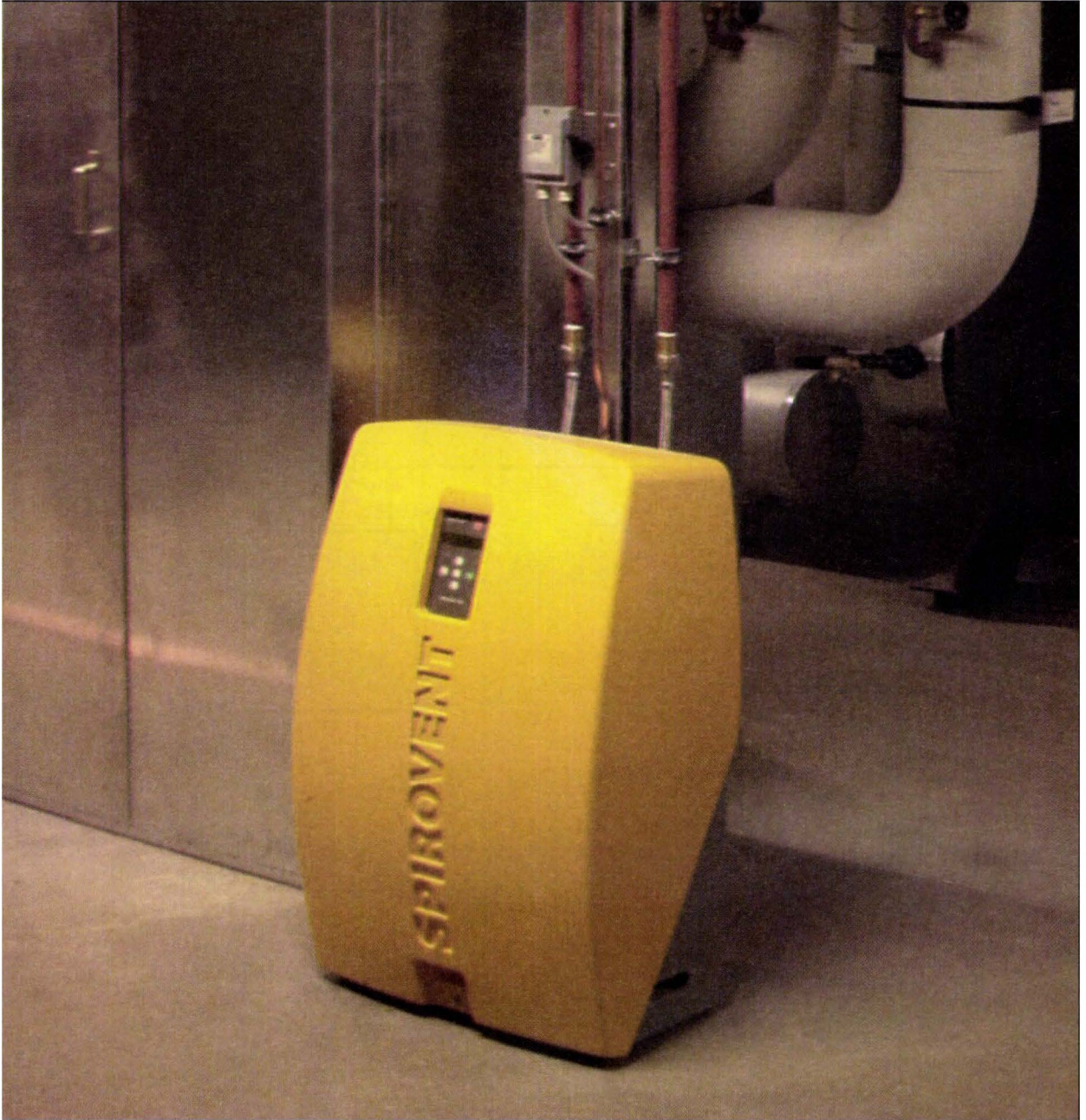
Şekil 4.79. ISISAN SUPERIOR HAVA AYIRICI UYGULAMA ÖRNEĞİ
